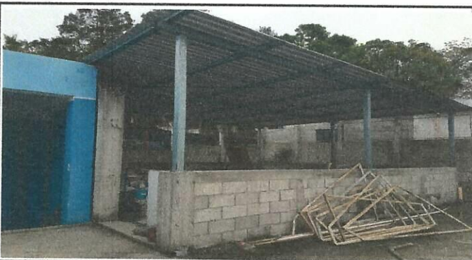
Foto 4: BALCONES DONDE VAN LAS VENTANAS
